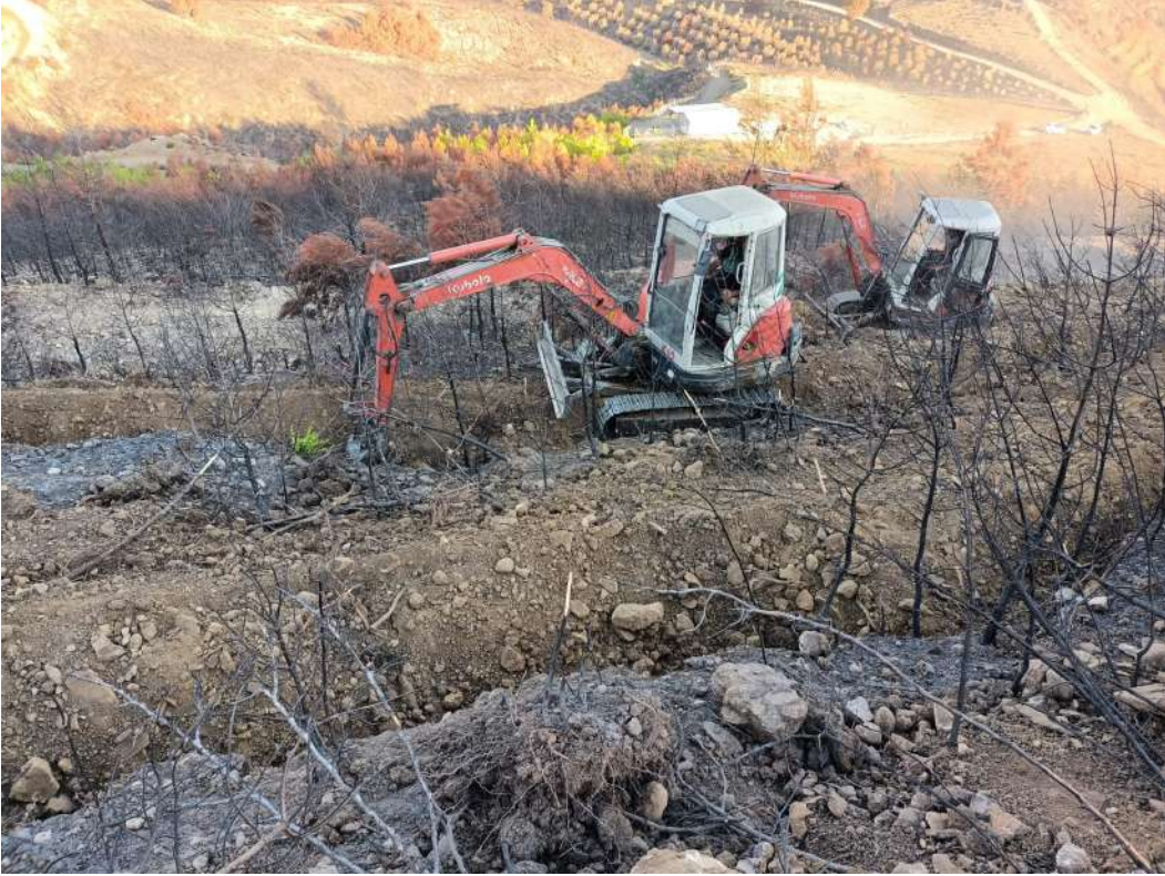
Mini Ekskavatörle Teras Yapımı
